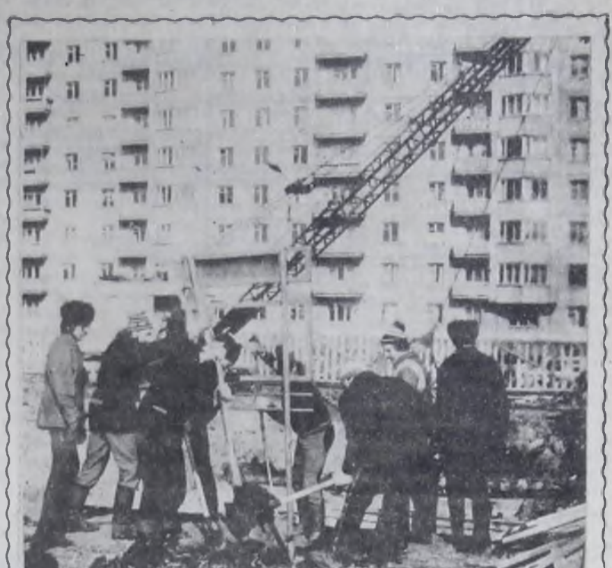
Наверное, эта фотография потом, через много лет, станет музейной реликвией. Ее поместят под стекло и будут в числе первых экспонатов показывать экскурсантам. И говорить при этом: «Товарищи, вы видите этап подготовительных работ на строительстве первого в Ангарске МЖК».
