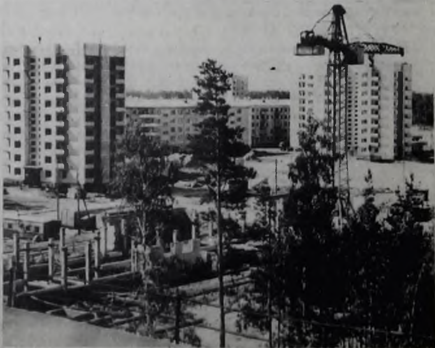
Ангартс строится. В 17-м микрорайоне.
