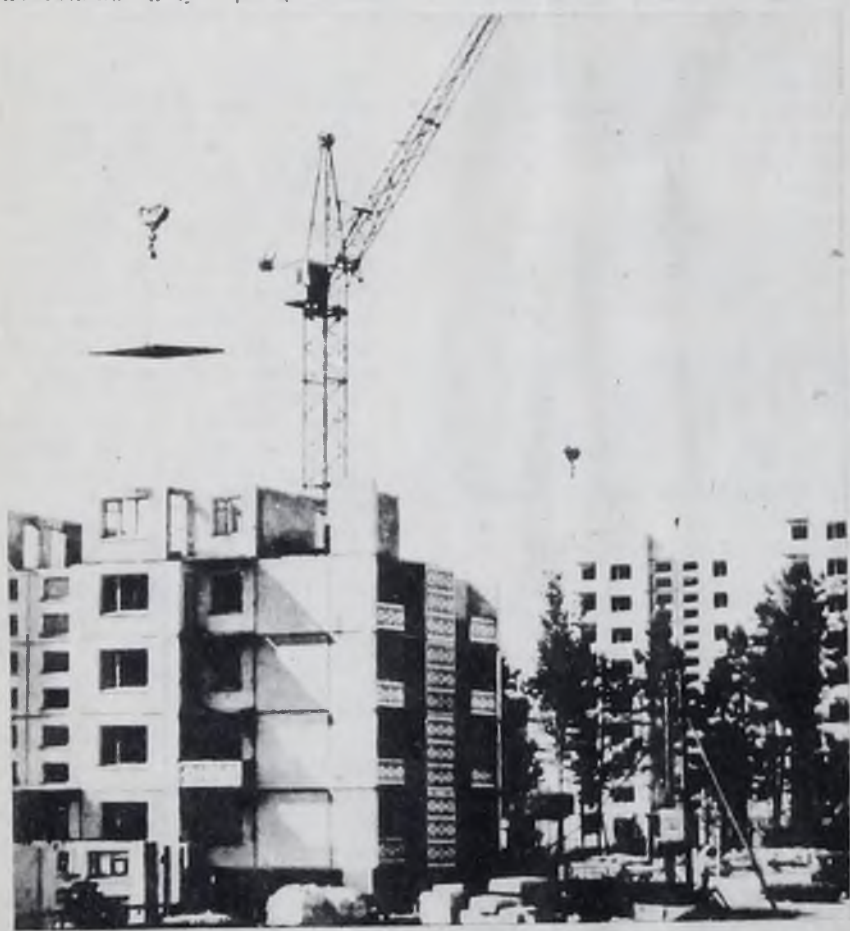
Строится 15а микрорайон.
