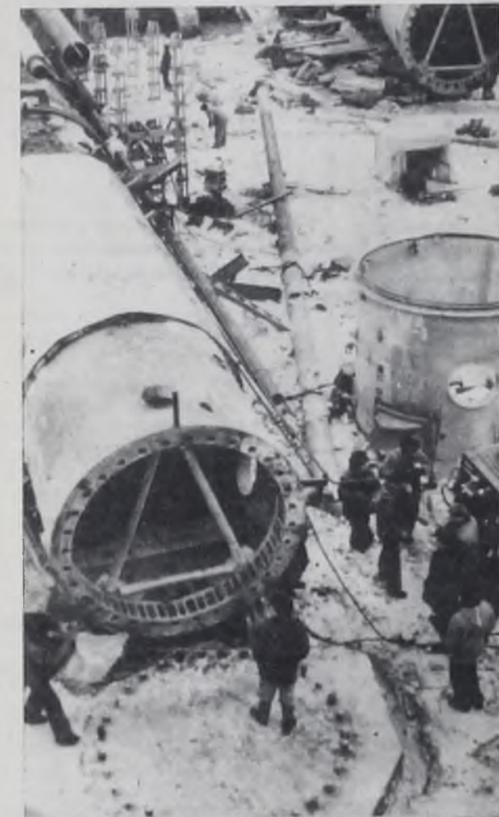
— Заканчиваем подготовку абсорбционной колонны к подъему, — рассказывает бригадир монтажников Аркадий Петрович Пятых со второго участка АМУ-2. — Колонна массивная. В длину 59 метров и диаметром около четырех метров.
