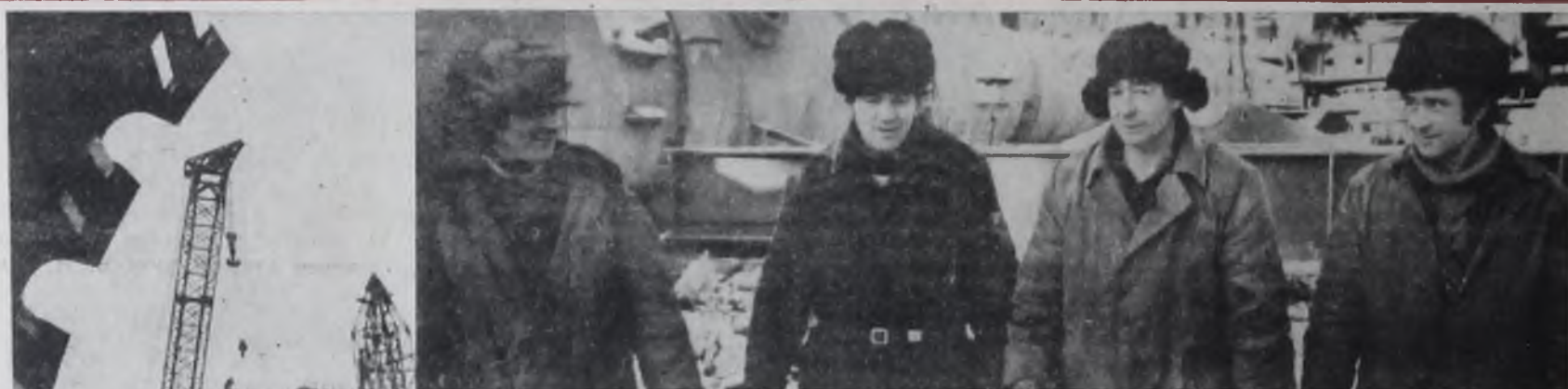
В дни работы XXVI съезда КПСС бригада Аркадия Петровича Пятых из АМУ-2 готовится к подъему одной из колонн блока абсорберов на комплексе аммиака и карбамида. Колонна эта длиной 64 метра. Ее
