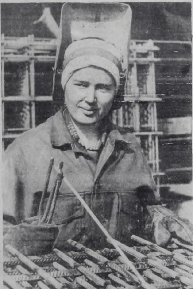
На площадке арматурного цеха голубые всплески и пламени вспыхивают из-под электродов склонившихся над сплетениями арматуры мастеров электросварки. С ветеранами ЖБИ-1 соревнуются молодые рабочие. Электросварщица Вера Чеботарева — одна из них, она ударник коммунистического труда.
