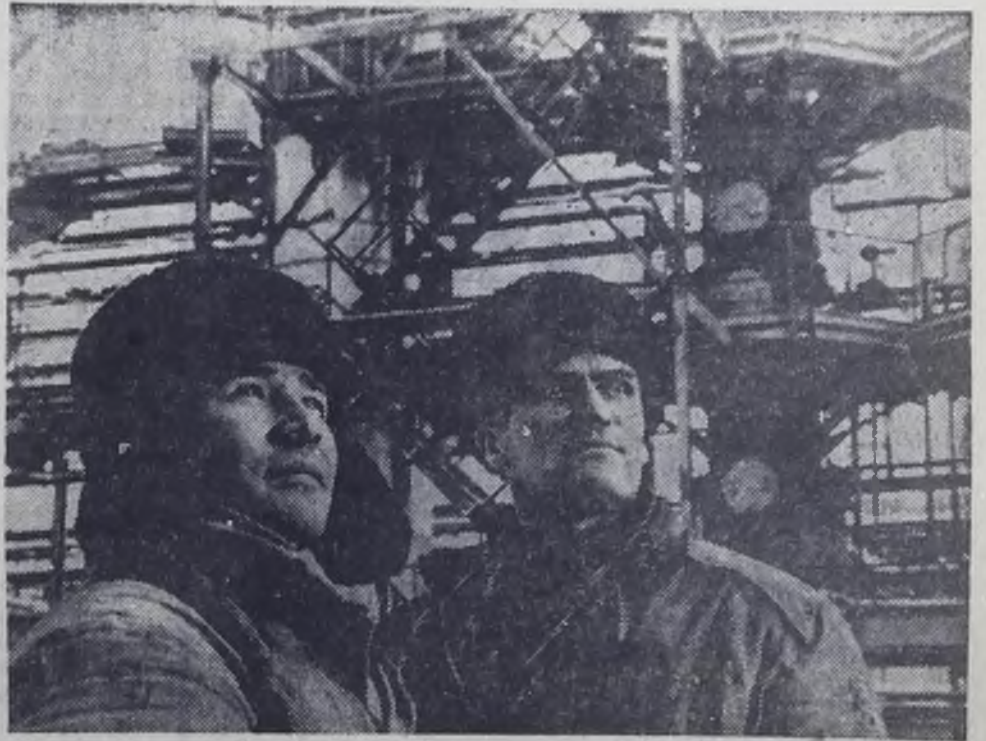
Строющийся комплекс «Вилена» — ударный объект этого года. Сейчас здесь сконцентрированы основные силы строителей и монтажников. Большой объем работ предстоит сдать здесь монтажникам МСУ-42.
