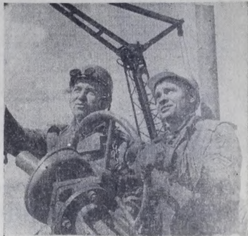
На пусковом комплексе стиролов работы вступают в самую ответственную фазу. Монтажники МСУ-42 вплотную приступили к гидроспытанию оборудования и трубопроводов, тем самым предоставив широкий фронт смежникам-изоляционщикам из Союзтеплоизоляции. На снимке: монтажники МСУ-42 В. Сорокин (слева) и А. Ильчук. Фото А. СТАВИНОВА.
