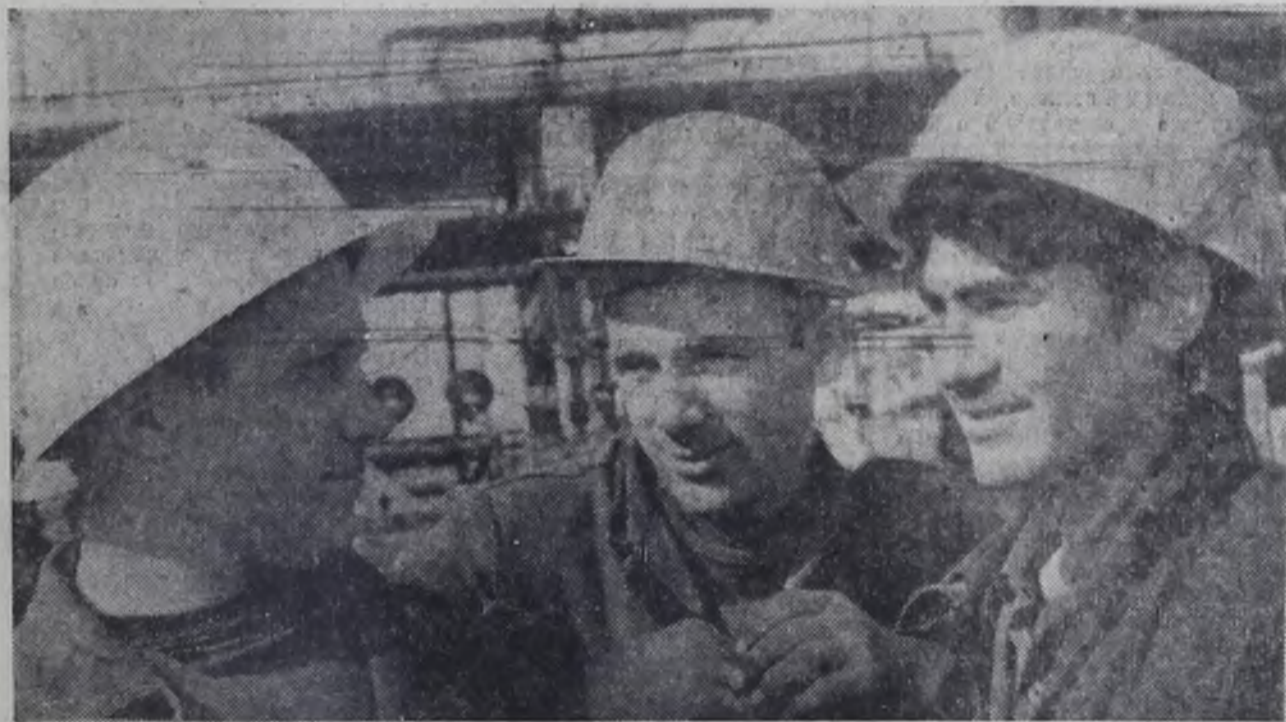
По-ударному сегодня трудятся на строительстве ЭЛОУ АВТ молодые монтажники треста Сибмонтажавтоматика. Иван Зеленков, Игорь Мих-
