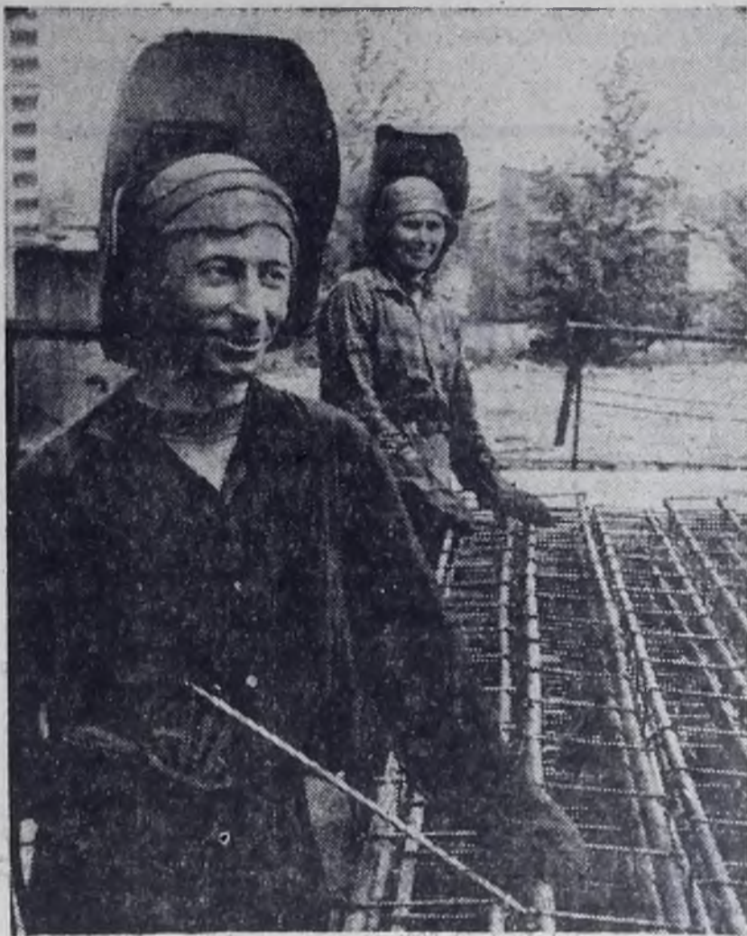
На заводе железобетонных изделий № 1 Олега Александровича Комлюка знают как отличного электросварщика, передового рабочего. К Дню строителя его труд был отмечен почетной грамотой.
