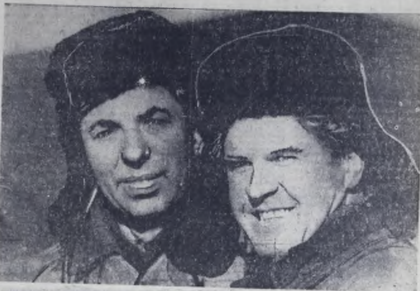
Сегодня на пусковом комплексе ЭЛОУ АВТ монтажники АМУ-2 треста Сибхиммонтаж Владимир Наливайченко и Николай Балашов ведут сборку уникальных колонн. Фото А. ХАМЗИНА.
