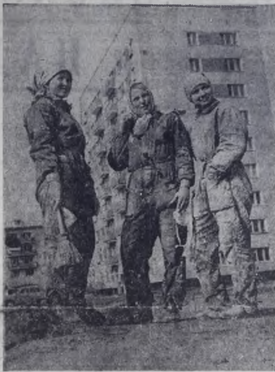
Еще один 9-этажный дом в 11-м микрорайоне готовят к сдаче строители города. Сейчас здесь идут полным ходом отделочные работы, которые ведут отделочники 4-го участка СМУ-5.
