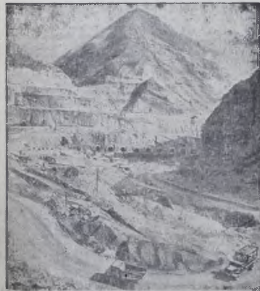
ТАДЖИКСКАЯ ССР. На строительной площадке Нурекской ГЭС с каждым днем ширится фронт работ в котловане под здание электростанции.
