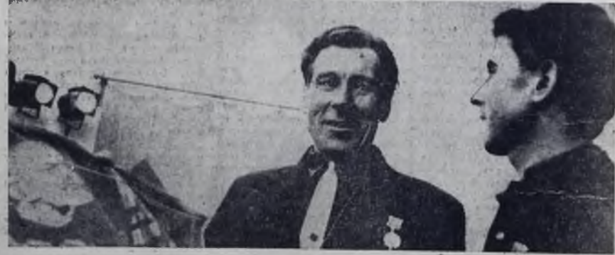
С отаженными трудовыми показателями пришли к 100-летию юбилею Владимира Ильича Ленина труженники управления подобный предприятий треста Востокхиммонтаж. В социалистическом соревновании, посвященном 100-летию юбилею, первое место по управлению заняла бригада слесарей-сборщиков Александр Иванович Ромоскиев, второе место заняла бригада токарей, которую возглавляет Николай Емельянович
