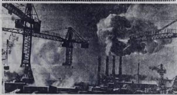
Ангарск. Заводы строительной индустрии.
