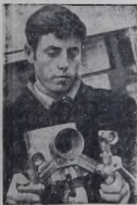
МОСКВА. Этот инструмент, позволяющий полностью механизировать процесс нанесения гидроизоляции при устройстве кровли, применяется средствами треста Калининстрой № 1. Он закрепляется ремнями на груди рабочего и распыляет на обрабатываемую поверхность (любой формы) крошевый стекложгут, смоченный битумно-латексной эмульсией. Применение такого «стеклодега», который можно увидеть сейчас на ВДНХ СССР, дает возможность втрое сократить трудовые затраты и на 30 процентов снизить себестоимость работ. Фото О. Лазаренко. Фотохроника ТАСС.
