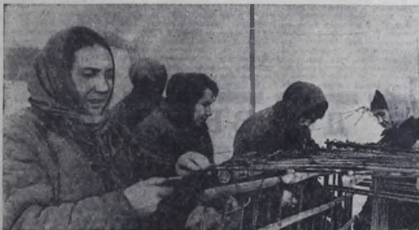
Отлично трудятся на строительстве бетонных эстакад бригады строителей СМУ-7 Н. Голуба и И. Даниленко. Ежедневно они выкладывают норму выработки на 130 и более процентов.
