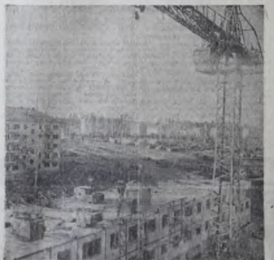
Братск продолжает строиться. Жилые кварталы растут с огромной быстротой, движаясь в сторону искусственного моря на Ангаре. 80—100 тысяч квадратных метров жилой площади ежегодно сдают строители города. На снимке: строительство жилых домов в Братске. Фото В. Белокоялова, АПН.
