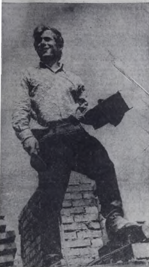
11-м микрорайоне началось строительство девятиэтажных до- точечного типа. Строит их бригада Н. Мирошника. Сейчас она возводит второй этаж.
