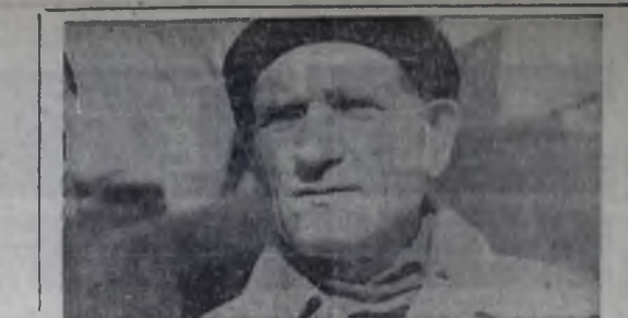
Кирилл Васильевич Подавусов — бригадир монтажников СМУ-3. С 1910 года работает он в строительных организациях: возводил мосты после войны, строил выгнутый дом в Москве на Сивцевской площади, участвовал в строительстве Московского университета на Ленинских горах. А в 1960 году приехал в Ангарск. Объекты нефтехими, нефтеперерабатывающего завода. ТЭЦ-1, ТЭЦ-9, ТЭЦ-10 — вот первые строительные плаэмоды, на которых ему пришлось работать в нашем городе.
