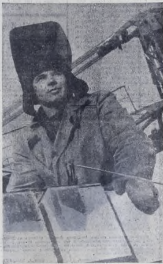
Много лет на строительстве города работает сварщик Алексей Сергеев. Бригада, в которой он работает, начала строительство очередного дома в 11-м микрорайоне. На снимке: А. Сергеев.
