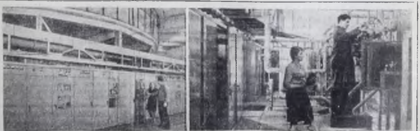
МОСКВА. Тысячи монтажников, строителей, отделочников, специалистов связи работают сейчас на строительстве Останкинского телестроения и телевизионной башни, которые намечено завершить к 50-летию Великого Октября. Сейчас в помещениях телешаши идет наладка телевизионных передатчиков, которые будут вести передачи по 1, 3, 8 и 11 каналам Центрального телевидения, закончен монтаж передатчиков частотной модуляции, полностью оборудованы аппаратные междугородных входных и выходных линий, аппаратная городских трансляций. На снимках: телевизионный передатчик 1-й программы. Справа — инженер-лаборант К. Т. Тусева и старший электромеханик А. А. Даикуевский проверяют аппаратуру передатчика. Фото А. Стужина.
