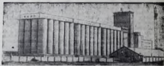
ТАДЖИКСКАЯ ССР. Вблизи города Кабржукма завершается сооружение крупнейшего в республике мельничного комбината. На строительной площадке висит корпус затвора емкостью в 45 тысяч тонн зерна. Мельничный комплекс в скором времени будет выпускать 240 тонн пшеничной муки. На территории предприятия поднимутся также рисовый и комбикормовый заводы.
