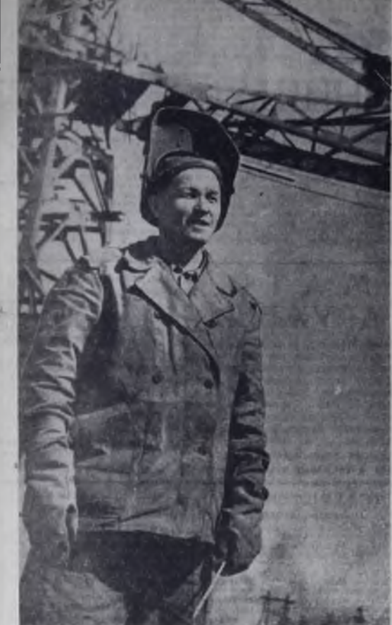
Василий Данилович Безногов работает электросварщиком на первом участке монтажного треста. Он настоящий мастер «голубого огня». За 30 лет своего трудового стажа Василий Данилович накопил немалый опыт в этой сложной профессии и охотно им делится с товарищами. Многие начинающие рабочие прошли у него школу сварки и сейчас самостоятельно работают. На снимке: ударник коммунистического труда В. Д. Безногов. Фото И. АМОСОВА.
