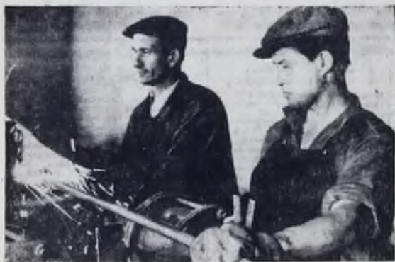
В отделения стыковарки арматурного цеха ЭЖБИ-1 быстро и четко идет работа. Здесь полномочными хозяевами являются мастера сварки металла Урсолович Николай и Черкашин Василий. Оба до-
