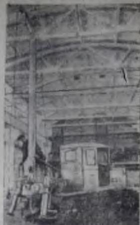
За 6 минут этот механизм, выпускаемый харьковскими экскаваторщиками, устанавливает опору для линии связи или низковольтных электросетей. Глубина ямы, которую бурит при этом установка, — 2,2 метра. Она безотказно работает в районах вечной мерзлоты.
