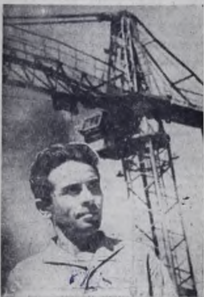
Хамнатов Хатмулла — бригадир бетонщиков-отделочников. Его бригада считается одной из лучших в 5-м цехе завода ЖБИ-1 УПП. Хамнатов служит примером для своих товарищей. Он ударник коммунистического труда.
