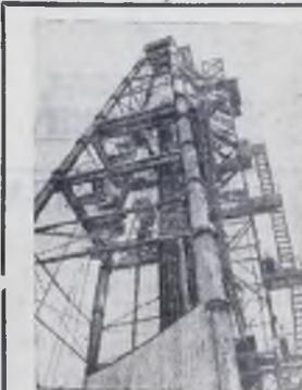
Необычная конструкция буровой вышки над узкой Шаховой косой на Амурском полуострове. На 70 метров поднимается вышка над землей, скважина уходит вглубь уже на 5 километров.
