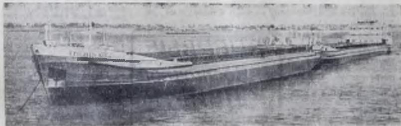
На Навашином судостроительном заводе построен самый крупный в мире речной теплоход. Его грузоподъемность — 10 тысяч тонн — в два раза больше теплохода типа «Воуго-Дон». Судно имеет два корпуса, сцепляемых специальным устройством. Обслуживает корабль команда из 21 человека.
