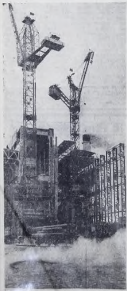
Это строится ГРЭС — энергетическая база растущей промышленности нового Забайкалья.
