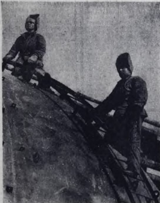
Одними из первых пришли на строительство Ангарского нефтеперерабатывающего завода монтажники треста Дальстальконструкция. Они строят парк резервуаров, шаровые дегазаторы, емкости. Более десяти лет работают на строительстве химических объектов ангарские сварщики Дмитрий Борисов и Юрий Варгола. Сейчас они ведут монтаж шаровых дегазаторов.
