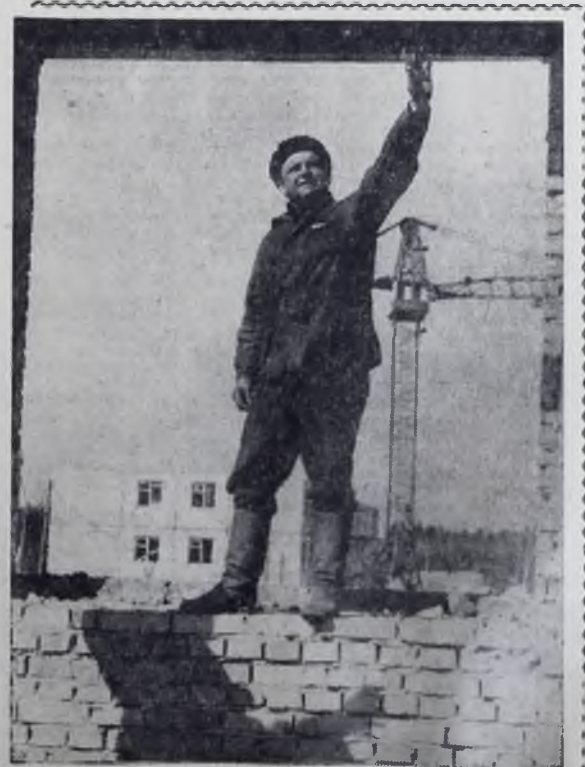
Много лет работает на строительстве Ангарска Пирог Владимир Антонович. Владимир возглавляет бригаду каменщиков. Его бригада ведет кладку совмещенного десяти-этажного на 280 мест. Это уже второй десяток в 12-м микрорайоне. Они обрядились сдать его под отделку к 1 мая. Фото А. КИСЕЛЕВА.
