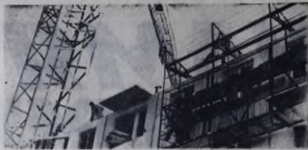
Вам, вероятно, приходилось видеть на стройках крупнопанельном доме подвесные леса. С помощью их рабочий задевает швы между панелями. Этим делом более 40 лет занимается старейший домостроитель Алексей Степанович Григорьев. Пожалуй, не найдешь в Ангарске дома, к которому бы не прикасалась рука Алексея Степановича. На снимках: А. С. Григорьев. Строительство в доме в 13 микрорайоне. Фото А. ХАМЗИНА и В. КУРЬЯНИНОВА
