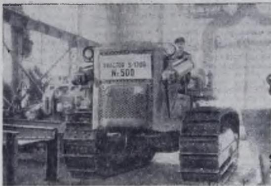
На заводе «Тракторул» в Брашове (Румыния) недавно начато серийное производство гусеничного трактора «С-1300». Новая машина снабжена мощным дизельным мотором. Она предназначена для механизации лесозаготовительных и гидромелиоративных работ «С-1300» это 20-й тип трактора, освоенный предприятием с начала его существования.
