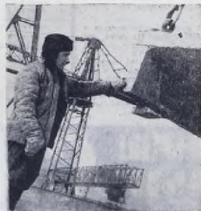
На снимке: старший электромонтер ТЭЦ НПЗ И. Пушкарев. Фото А. Елфимова.
