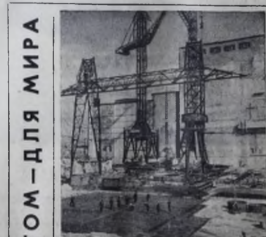
На снимке: строительство второго блока Нововоронежской атомной электростанции. Фото А. Зелина.
