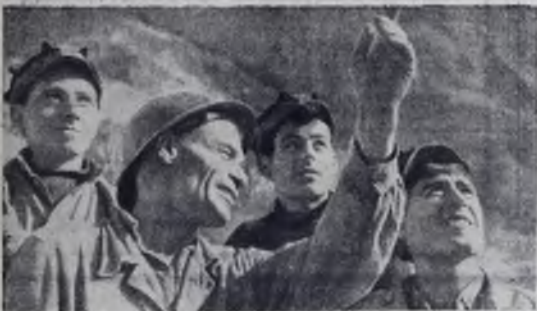
На снимке: передовая бригада бетонщиков на строительстве Нурекской ГЭС. Слева направо: М. Новоселов, бригадир П. Блохин, А. Жеребцов и В. Шутенко. Фото Р. Нетелева.
