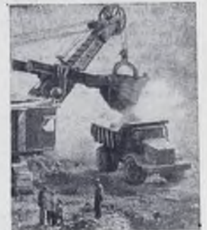
На снимке: земляные работы в котловане будущей Нурекской ГЭС.
