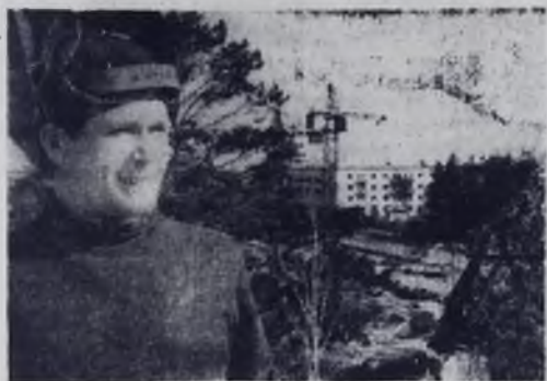
Сварщик Николай Казулин — ветеран на строительстве нашего города. 9 лет — таков его трудовой стаж на строительстве жилых домов. Познал он труд каменщика, монтажника, а сейчас Николай отличный сварщик.
