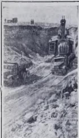
Все дальше в степь уходят строители канала Иртыш—Караганда. Мощный машинный парк стройки состоит из множества экскаваторов, скреперов, бульдозеров. Выемка грунта производится также с помощью взрывчатки. На снимке: на трассе канала Иртыш—Караганда. Фото К. Нуртазина. Фотохроника ТАСС
