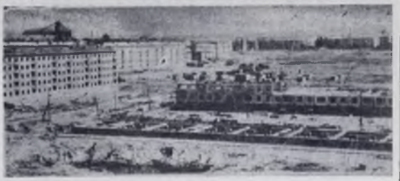
4 микрорайон Ангарска. Полным ходом идет строительство 100—120-квартирных домов. Совсем скоро ангарчане справят здесь новоселье. Фото А. ЕЛФИМОВА.
