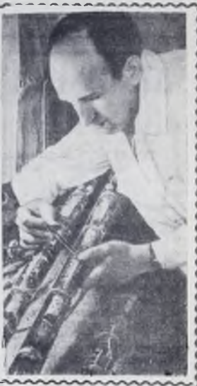
Москва. На заводе «Нефтеприбор» освоено производство новых типов промышленной геофизической аппаратуры — скважинных приборов для электрического и радиоактивного каротажа скважин. С их помощью можно проводить геофизические исследования в глубоких скважинах при давлении до 1000 атмосфер и температуре до 200 градусов. На снимке: регулирующий аппаратура А. В. Абрамова проверяет новое изделие. Фото Б. Третьякова. Фотохроника ТАСС
