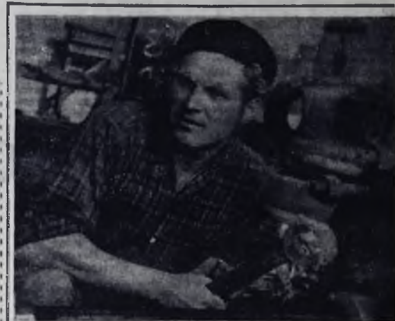
Полным ходом идет монтаж оборудования в насосной установке 35-6 НЛЗ. Монтаж ведет бригада Л. Стефановского.
