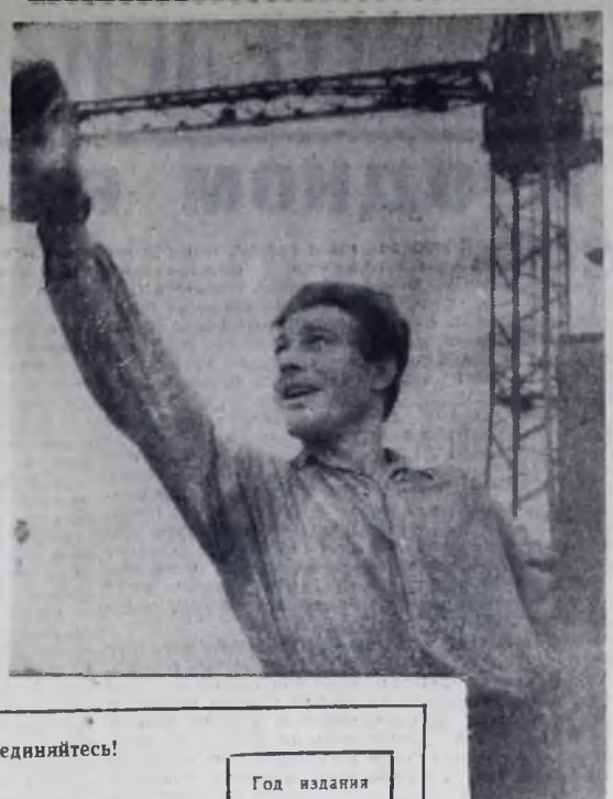
Сложная и ответственная работа у домостроителей. Сварщик Алексей Смирнов более 5 лет трудится на сооружении жилых домов. За это время он овладел многими специальными строительного искусства. Фото А. Елфинава.
