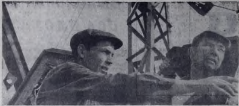
Замечательно работает бригада монтажников Союзтепlostройа Петра Севрюкова. Сейчас она монтирует печь на объекте 24/8 ИПЗ. На снимке: П. Севрюков и крановщик В. Черныгов.
