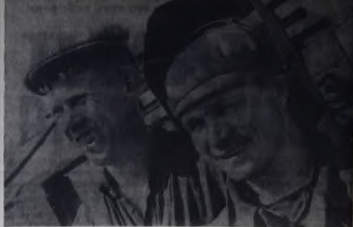
Совсем молодой считается в коллективе бригада монтажников В. Улич. Сейчас она трудится на сооружении эстакады в 14 квартале НПЗ. И, если судить по результатам, трудится неплохо.
