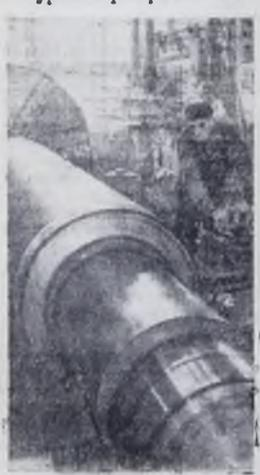
Ленинград. На заводе «Электросила» ведется обработка вала ротора турбогенератора мощностью в полмиллиона киловатт. Уникальная машина будет изготовлена в этом году для Славянской ГРЭС на Украине.
