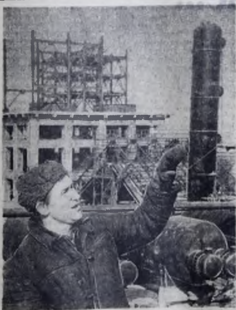
На нефтеперерабатывающем заводе все знают прославленную бригаду монтажников Михаила Федосеевича Скипора. Да и не мудрено. Ведь она трудится здесь с самого основания завода.
