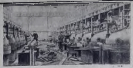
Быстрыми темпами ведется монтаж оборудования на стройке большой химии — Ефремовском заводе СК.
