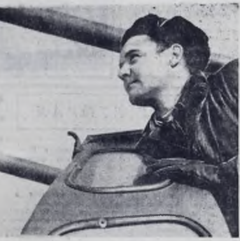
Умелые руки у машиниста дизель-крана Виктора Губарева. Работает он на сооружении эстакады технологических трубопроводов. Фото В. НЕБОГИНА.
