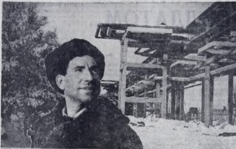
Дни пуска ЭЛОУ АВТ были днями героизма. Сотни людей здесь, на трудовом фронте, в трудных условиях декабря, вели успешное наступление на новых рубежах второй очереди НПЗ. И в первых рядах шли парни бригады Григория Дмитриевича Жукова, работающие на сооружениях технологических трубопроводов. На снимке: бригадир Г. Д. Жуков. Фото В. НЕБОГИНА.
