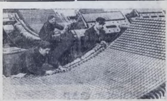
ЛЕНИНГРАД. За полярным кругом идет строительство Верхне-Тулумской ГЭС. Это будет одна из наиболее мощных гидроэлектростанций Кольского полуострова. Строительство ведется в сотрудничестве с финскими специалистами и рабочими. Электромашиностроители завода «Электросила» изготавливают гидрогенераторы для этой станции мощностью по 57 тысяч киловатт. На снимке: обмотчики В. Ф. Егоров (слева) и Л. Ф. Филатов ведут обработку первого статора гидрогенератора для Тулумской ГЭС. Фото И. Баранова. Фотохроника ТАСС.
